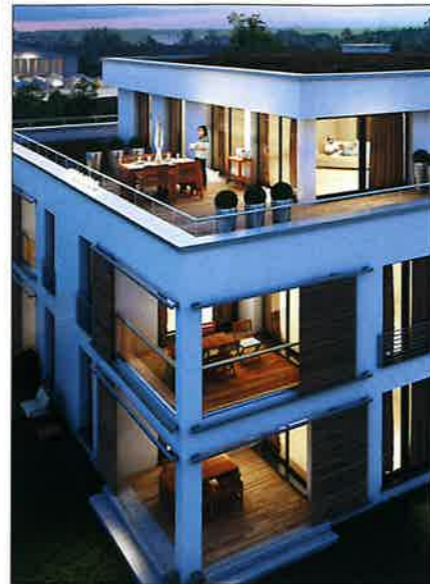
Erstellt wurde das Mehrfamilienhaus am Sulzpark in Beilngries mit holzfasergefüllten »Unipor Silvacor«-Mauerziegeln von Leipfinger-Bader. Das hochwärmedämmende Mauerwerk unterstützt eine konstante Raumtemperatur zu jeder Tageszeit.
