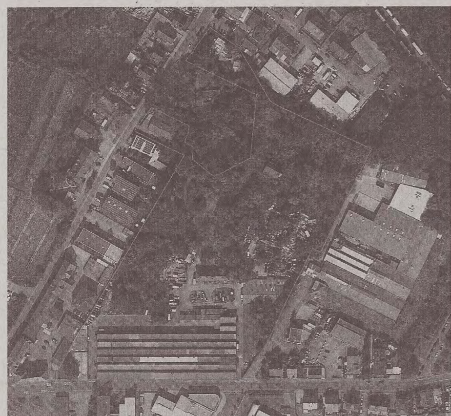
An der Raentaler Straße in Rastatt entwickelt die Hagedorn Unternehmensgruppe in Partnerschaft mit GDD Development eine rund 41 000 m 2 große Fläche. FOTO: HAGEDORN
