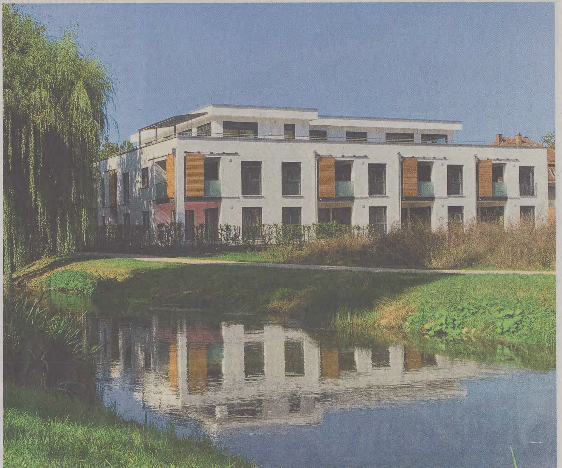
„Wohnen am Sulzpark“: Das im oberbayerischen Beilngries gelegene Mehrfamilienobjekt mit 14 Einheiten besticht durch angenehmen Wohnkomfort und seine grüne Lage.
